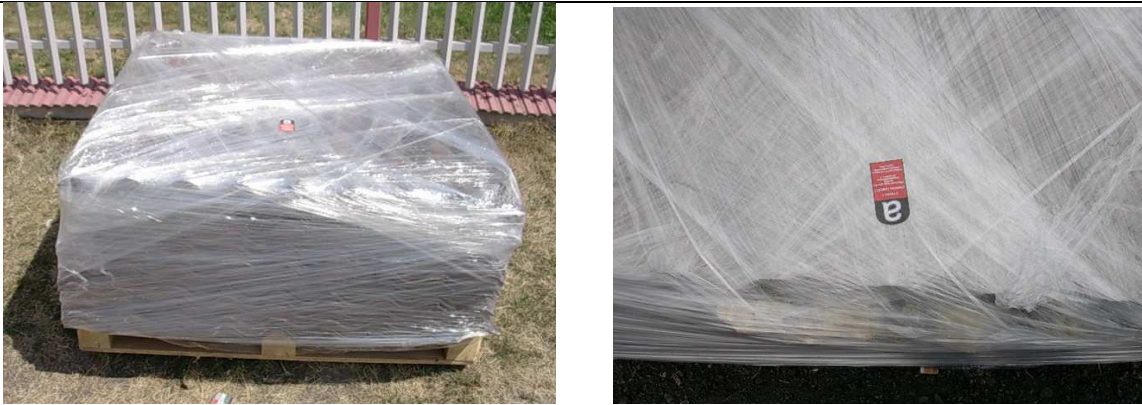
Zdjęcie nr 6. Prawidłowo przygotowane do transportu zdemontowane płyty azbestowo-cementowe (zdjęcia z usuwania eternitu na terenie miasta Piotrkowa Tryb., rok 2008).
