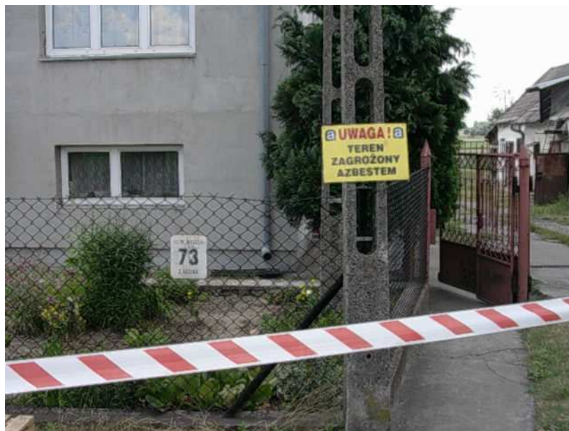
Zdjęcie nr 7. Prawidłowy sposób zabezpieczenia terenu zagrożonego azbestem (zdjęcia z usuwania eternitu na terenie miasta Piotrkowa Tryb., rok 2008).
